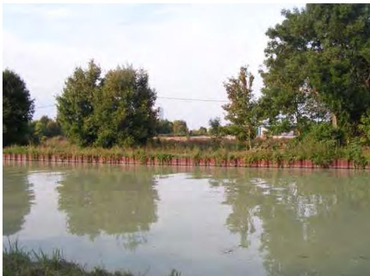
Les berges du canal de l'Aisne à la Marne font l'objet d'un soutènement par le biais d'un rideau de palplanche autostables ou ancrées et plus localement par des murs en ciment. Ce soutènement assure une protection efficace de l'ouvrage en préservant le rectangle de navigation du bêtillage. Cet avantage technique présente des inconvénients majeurs du point de vue écologique.
