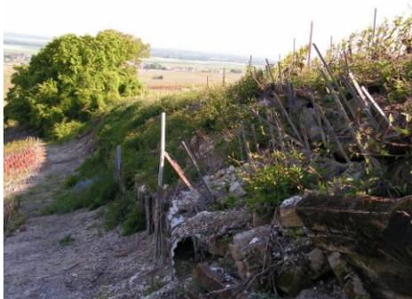
Ci-contre, échec d'un aménagement fortement sollicité par la poussée du substrat dans une situation de pente instable.
