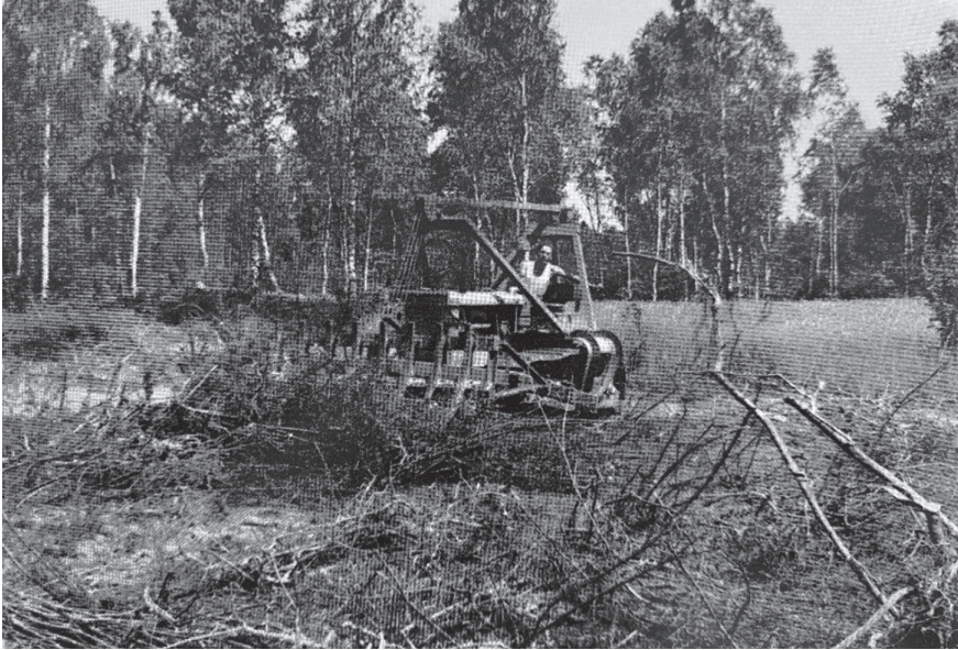
Figure 4. Défrichage à l’aide d’un bulldozer. Commune de Moivre
